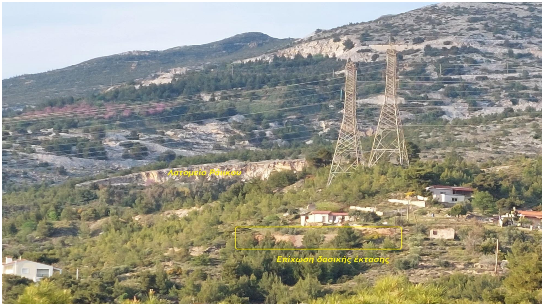
Άποψη από Νέα Πεντέλη - Διακρίνεται η επίκωση ύψους 3-4 μέτρων
